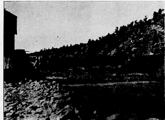
Slag Dam of B. V. S. & R. C. at Buena Vista.
